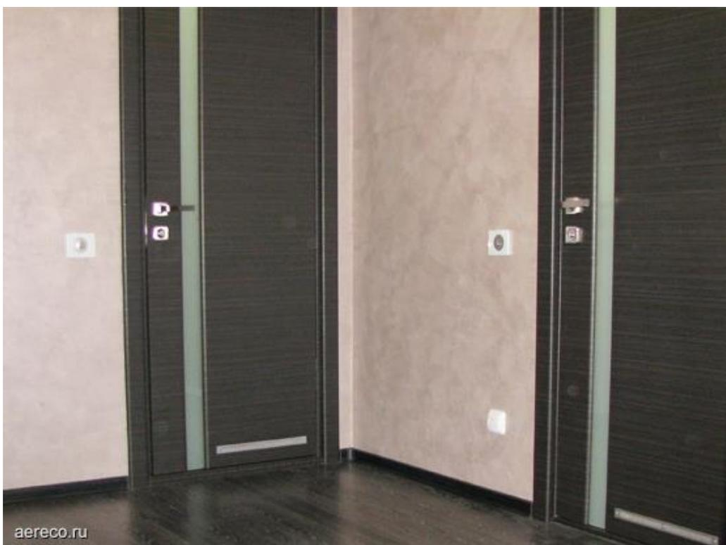
Переточные решетки, установленные в нижней части межкомнатных дверей.
