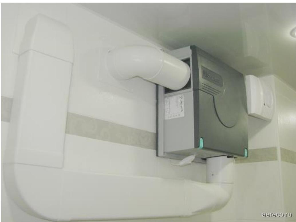
Установленный на стене [вентилятор V2A](#) с пластиковыми воздуховодами разного сечения и подсоединенным вытяжным устройством ВХС.
