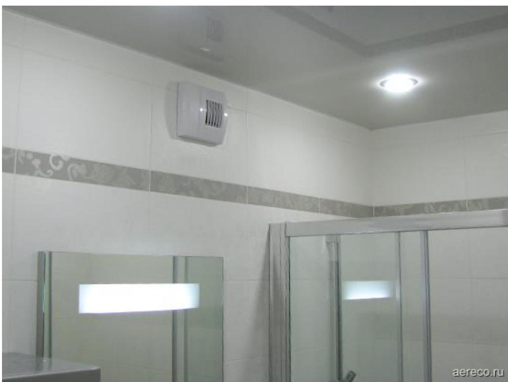
[Вытяжное устройство VXS](#), установленное в ванной комнате.
