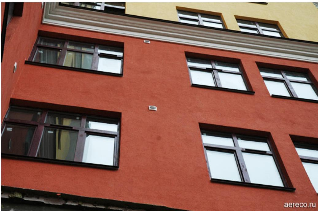
Белые наружные козырьки прикрывают на фасаде дома отверстия для стеновых клапанов Аересо.
