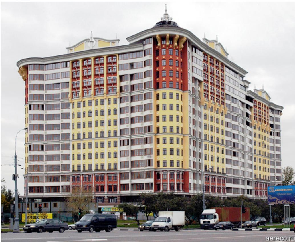
Жилой комплекс «Белый лебедь» с естественной системой вентиляции. Приток воздуха организован с помощью оконных и стеновых клапанов Аегесо.
