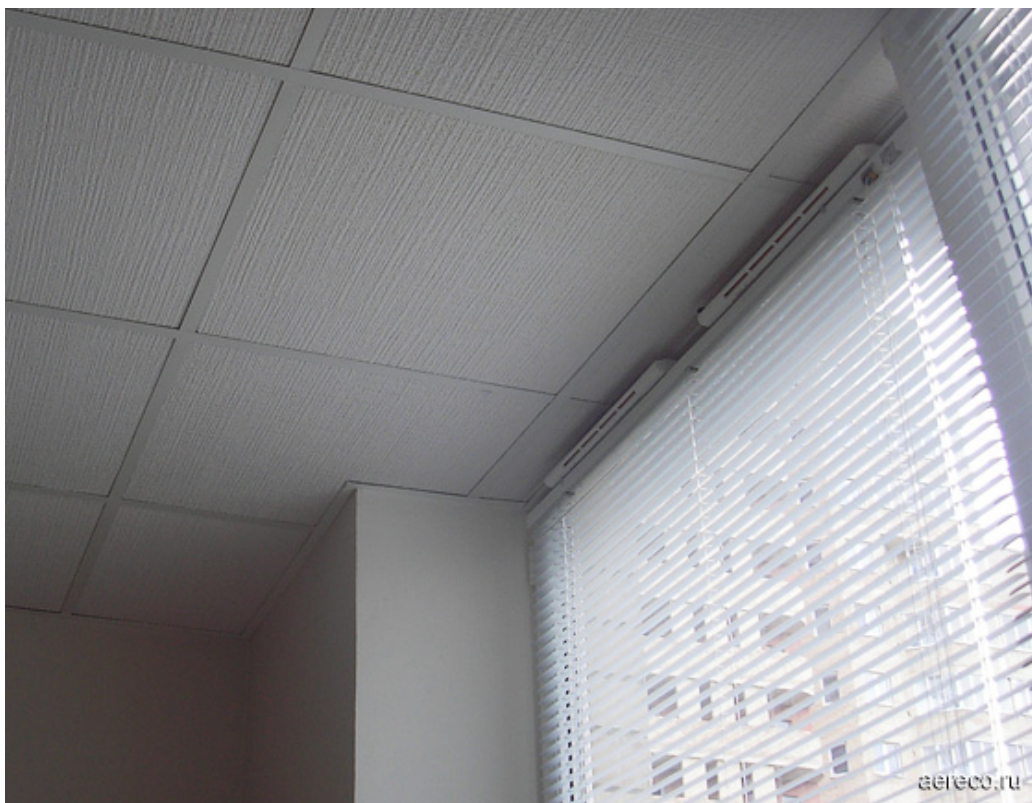
Приточные клапаны EMM, установленные в верхней части окна.
