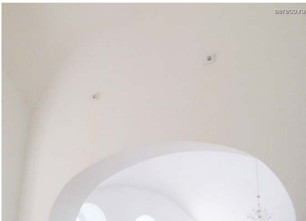
Вытяжные устройства VXL, расположенные над арочным проходом, ведущим в восточную часть храма.
