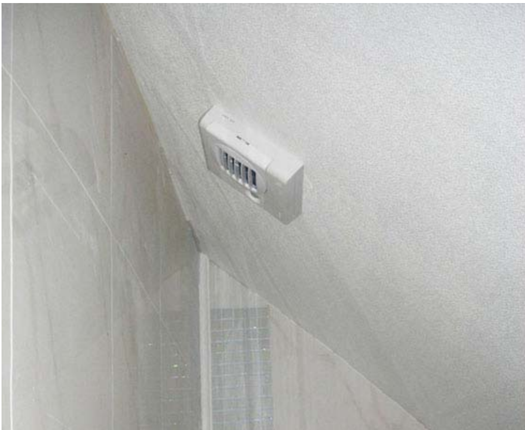
Вытяжное устройство BXS, установленное в санузле в мансарде.
