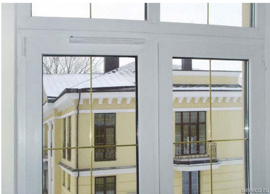
Внешний вид установленного на окне приточного клапана EMM. Несмотря на свои небольшие габариты, данное устройство обеспечивает приток воздуха до 35 м 3 /час при 10 Па.
