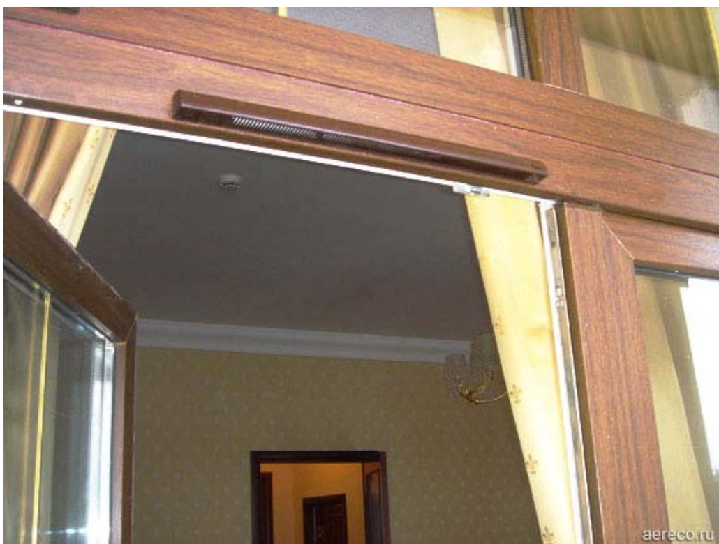
Установленный на окне защитный козырек ASAM (цвет – «тик») с решеткой от насекомых.
