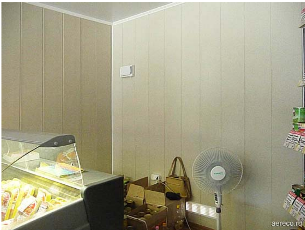
Стеновое гигрорегулируемое приточное устройство ЕНТ обеспечивает расход воздуха от 5 до 40 м 3 /ч. При 10 Па.
