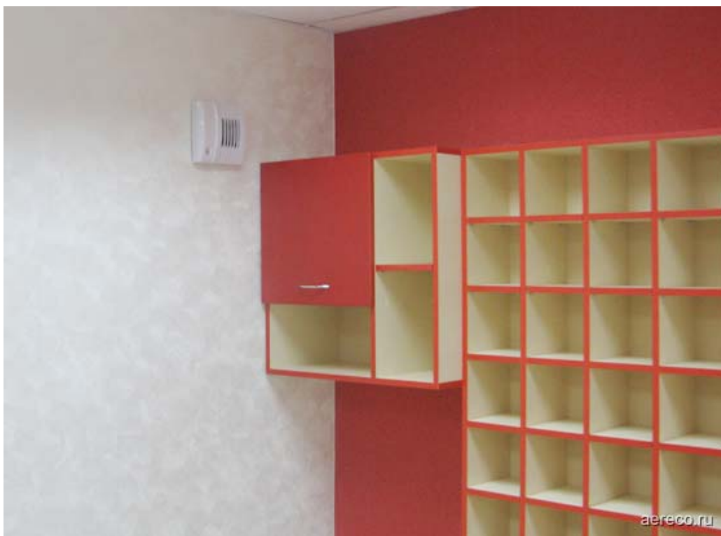
Вытяжное устройство VXC с датчиком присутствия обеспечивает до 130 м 3 /ч при пиковом расходе воздуха.
