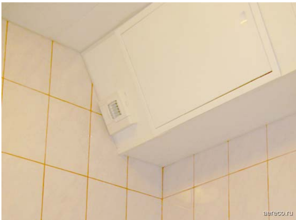
Вытяжное устройство BXS, установленное в санузле. Наличие ревизионного люка значительно облегчает доступ к вентилятору для технического обслуживания.
