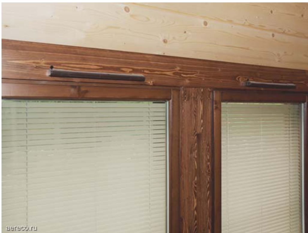
Приточные устройства EMM (цвет – тик), установленные в современные деревянные окна.
