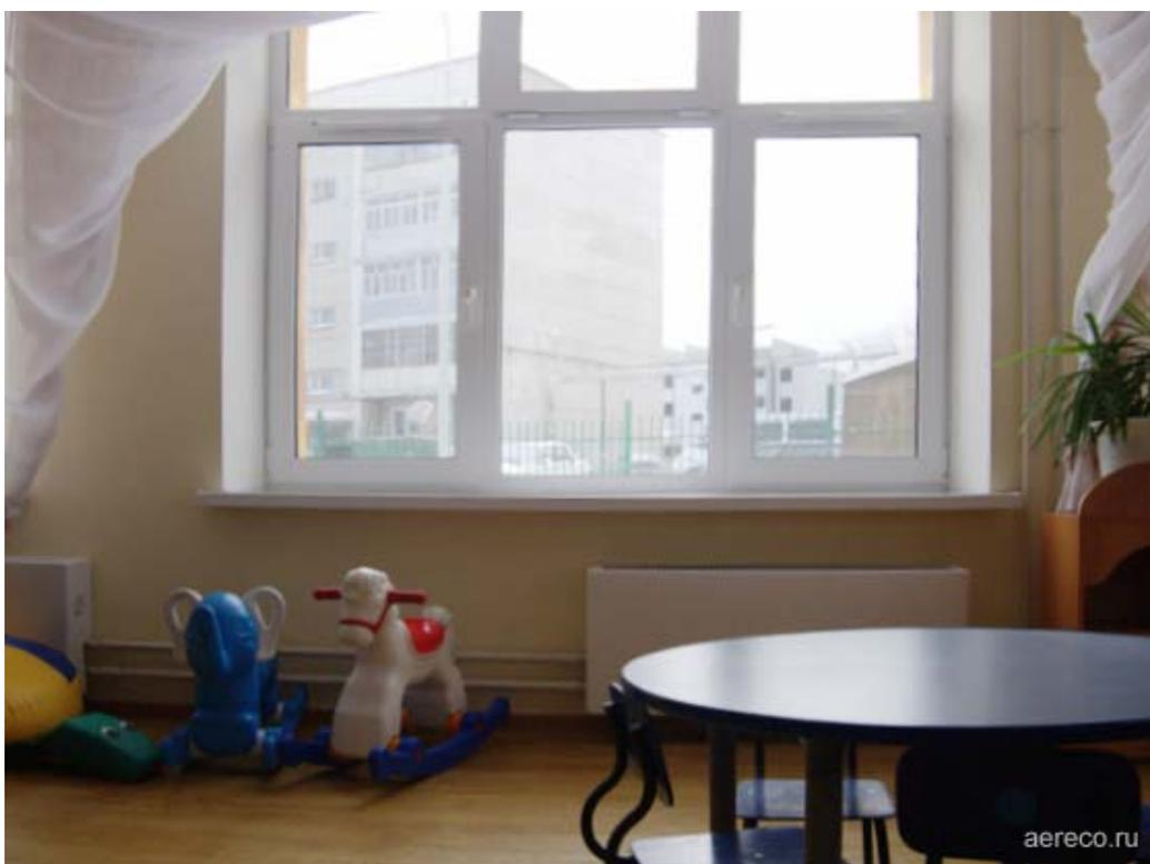
Типовой оконный блок с приточными клапанами Аегесо, установленный в ясельной группе на первом этаже.
