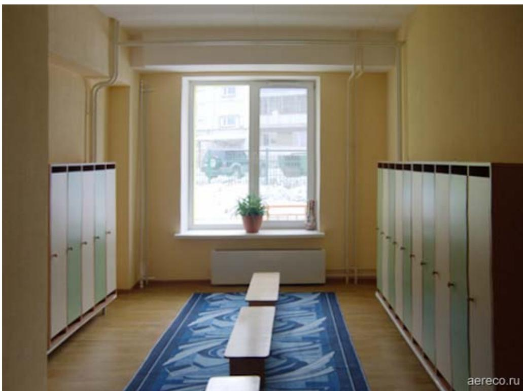
Раздевалка. В верхней части окна установлен приточный клапан EMM, обеспечивающий приток воздуха до 35 м<sup>3</sup>/ч при 10 Па.
