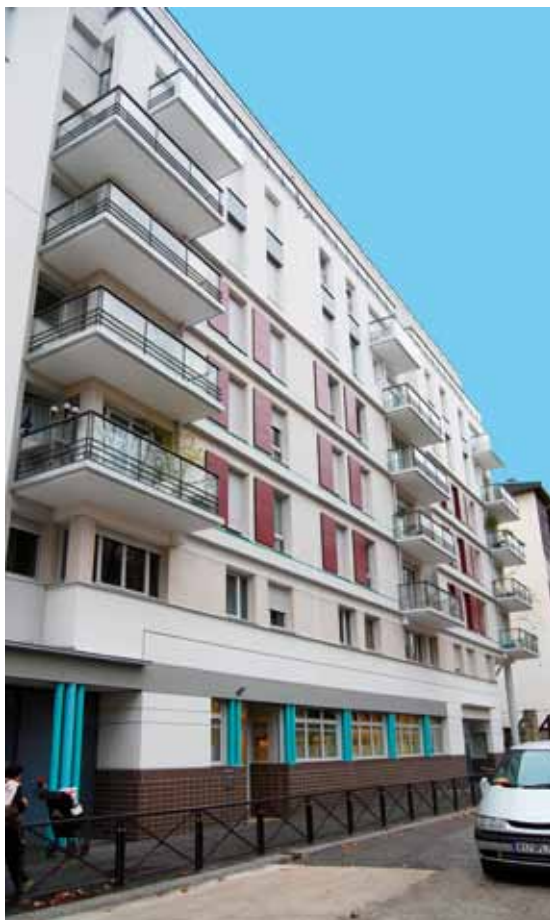
Строительный объект в Париже
